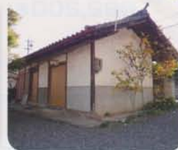
土壁の施工前外観
